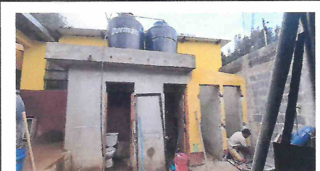
FOTO NO. 4 SE CAMBIARAN 2 SANITARIOS POR NUEVOS
