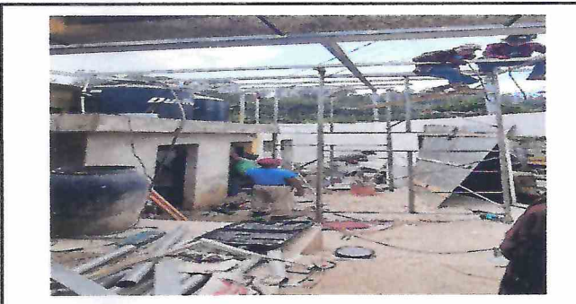
FOTO NO. 6: TECHO AREA DE BAÑOS Y PATIO
