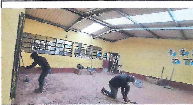
FOTO NO. 1 NIVELACION DE PISO, EL PISO NO SOLO TIENE LEVANTADA LA CAPA DE PISO SINO QUE TAMBIEN ESTA DESNIVELADO CASI LOS 20 CM
